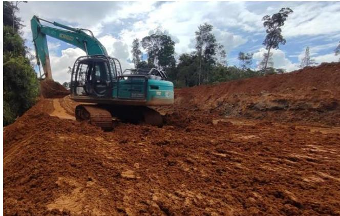
Gambar 4. 4 Timbunan Tanah
