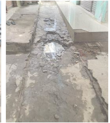
Gambar 1.3 keadaan jalan dalam pasar sumber : observasi lapangan (2022)
