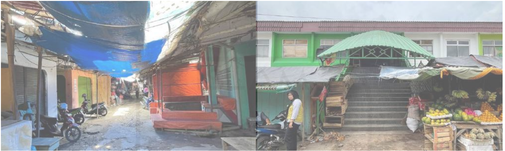
Gambar I. Kondisi Pasar Sumber : Observasi Lapangan (2022)
