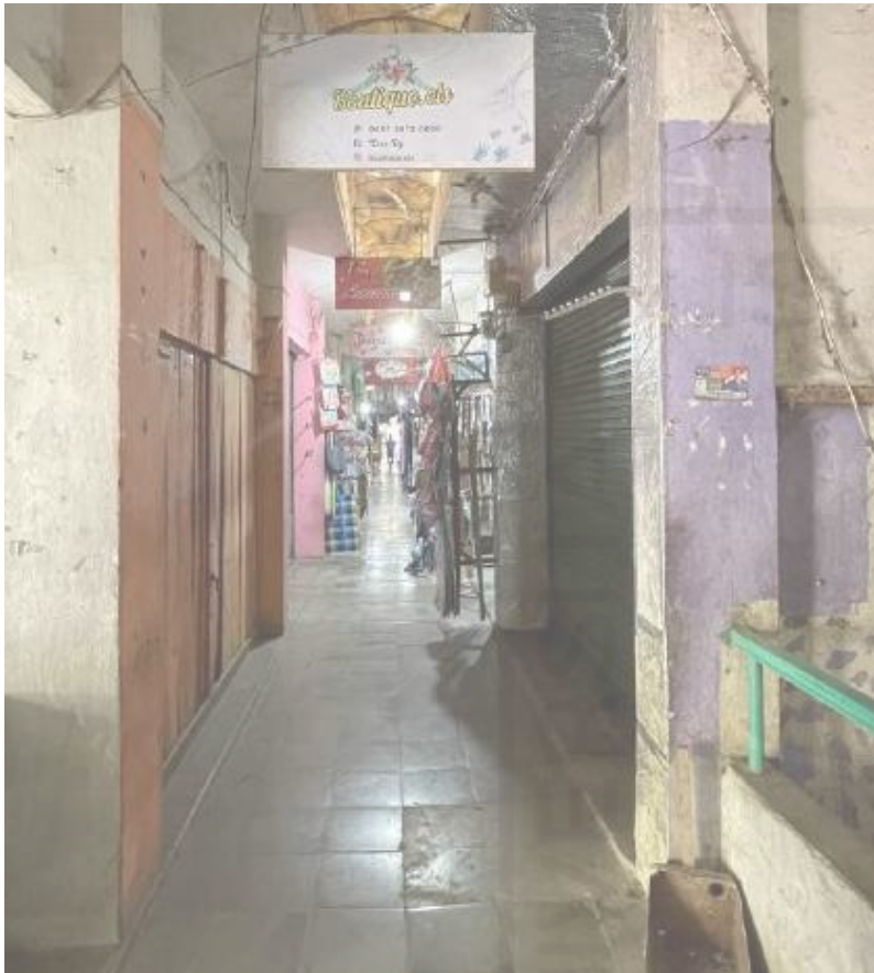
Gambar III. Keadaan Koridor Pasar Sumber : Observasi Lapangan (2022)
