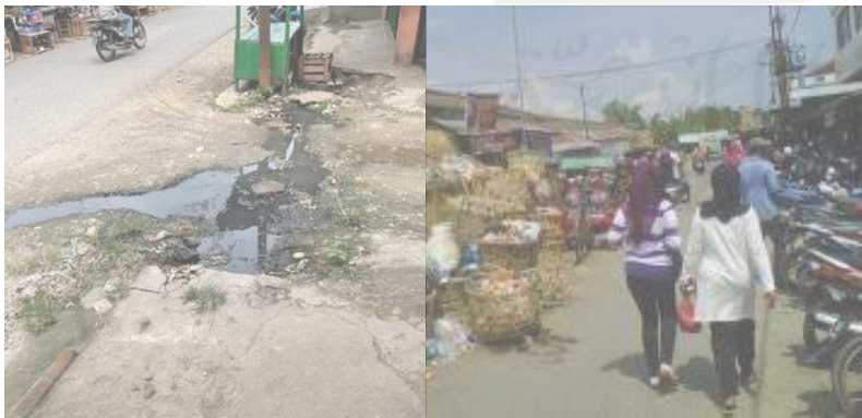
Gambar 1.4 situasi selokan sumber : observasi (2022)
