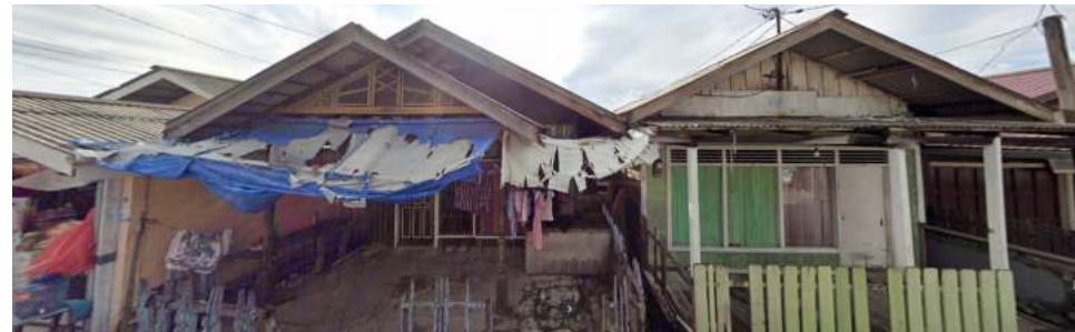
Gambar 2.7 Kondisi Fisik Bangunan RT 1 Baru Ulu Sumber : googlemap
