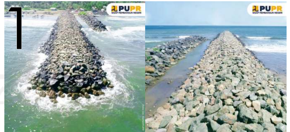
Gambar 2.13 Pembuatan Jeti menggunakan material batu armor Sumber : PUPR, 2021
