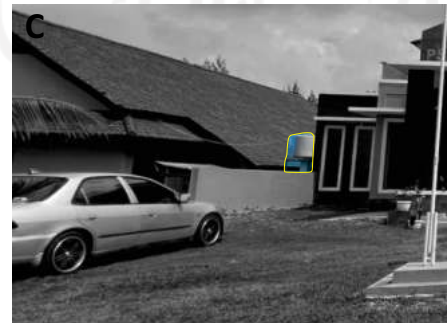
Lokasi Toren Air di Area perkantoran
