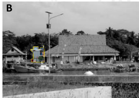
Lokasi Toren Air di Tempat Pelelangan Ikan dan Pabrik Es
