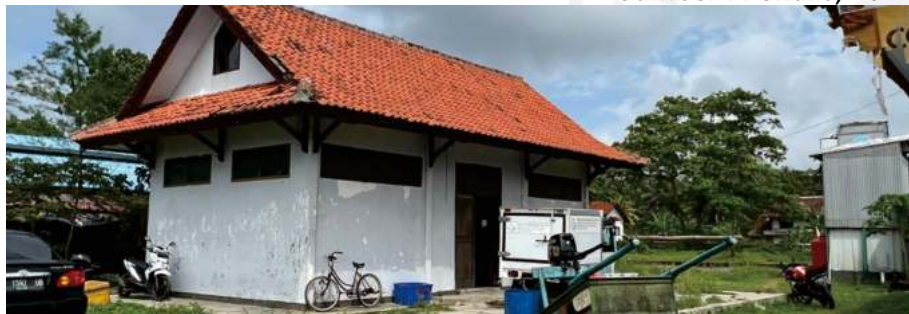
Gambar 1.9 Instalasi Pabrik Es Sumber : Penulis, 2022
