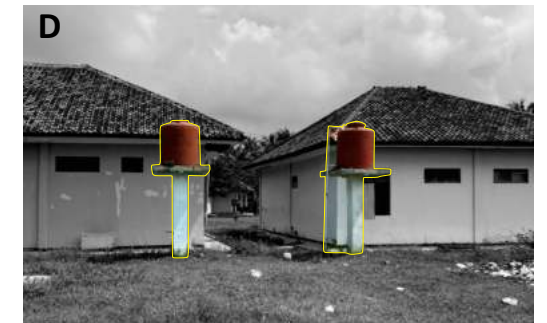
Lokasi Toren Air di Area perkantoran
