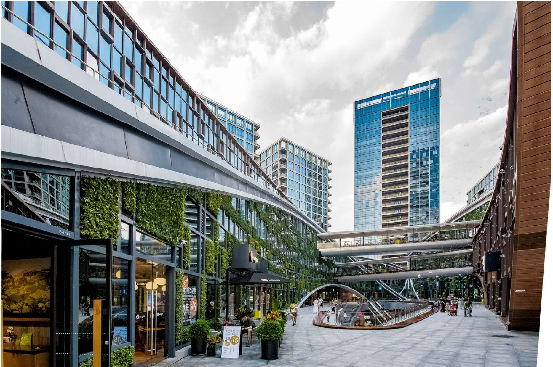
Sirkulasi pada Building 12 Qplex di Shenzhen, China. Sebuah Shopping Mall dengan Kombinasi Fungsi Ruang Publik (Abdel, 2020).
