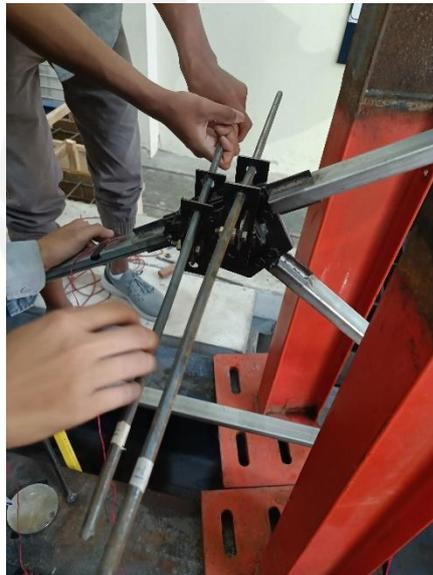
**Gambar 5.40 Proses Meluruskan Kembali Pelat Sambung yang Tekuk**
