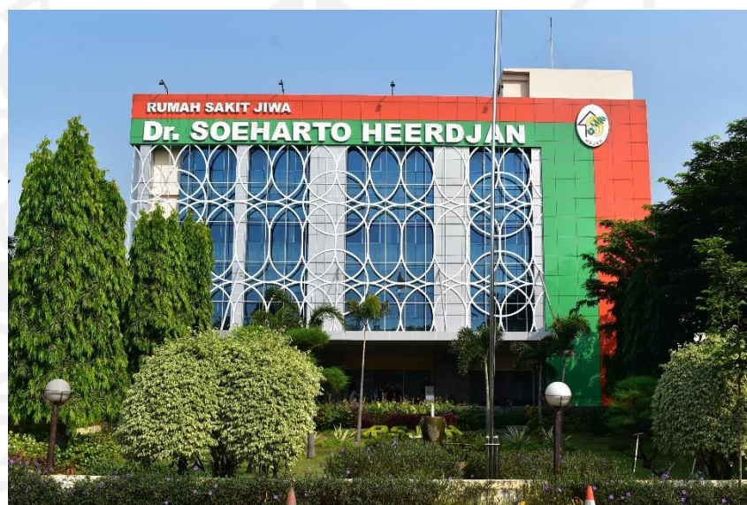
Gambar 1.1 Gedung Rumah Sakit Jiwa Dr. Soeharto Heerdjan
