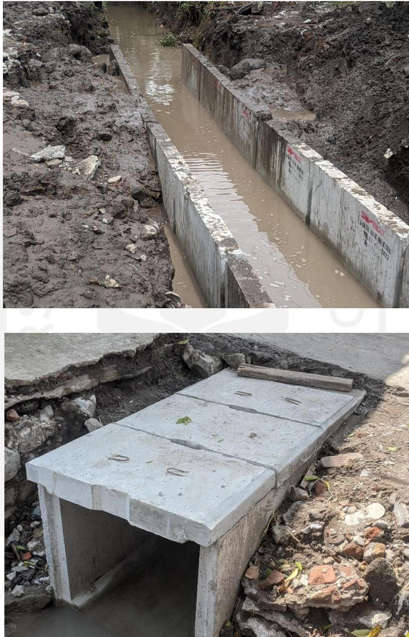
**Gambar L 3.3 Beton *u-ditch precast* yang sudah dipasang pada galian**
