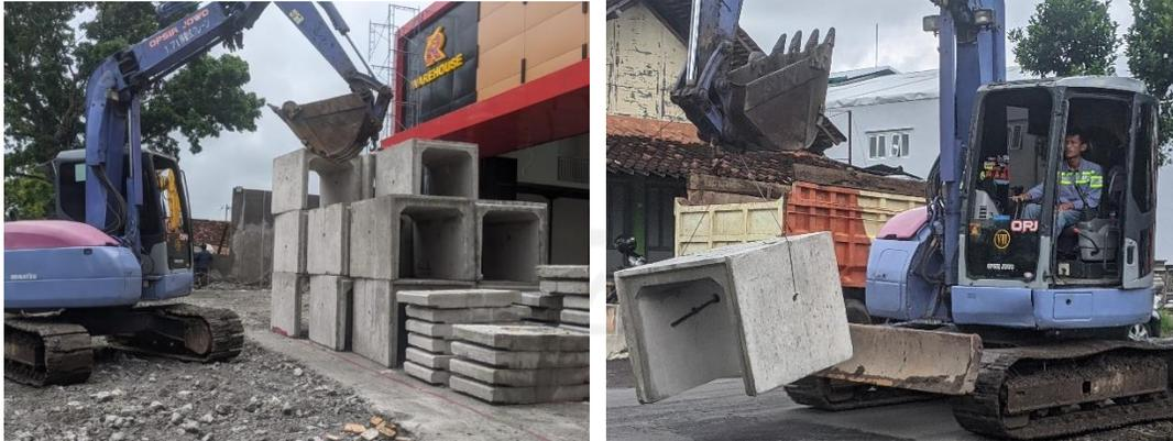
**Gambar L 3.3** Alat berat yang ingin mengangkat beton *u-ditch precast*
