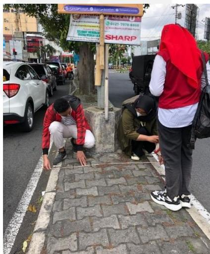
**Gambar L-7.2 Pengukuran Geometrik**
