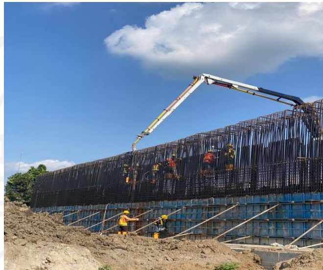
Dokumentasi PT. Adhi Karya Gambar 4 Abutment jembatan
