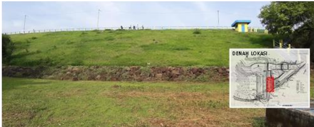
L-1. 3 Kondisi Lereng Hilir
