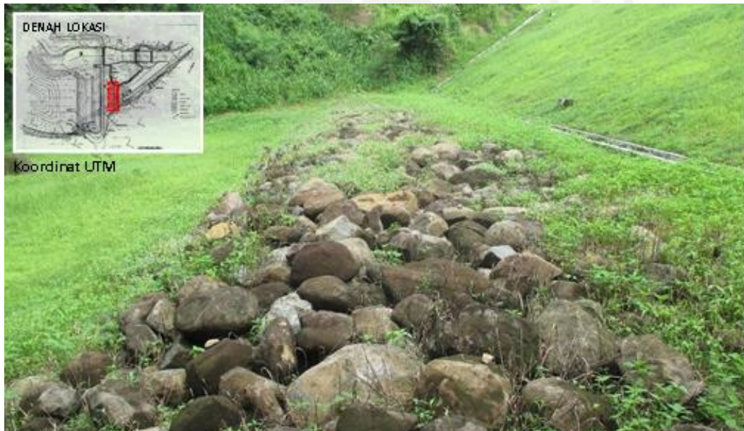
L-1. 4 Kondisi Puncak Cofferdam Hilir
