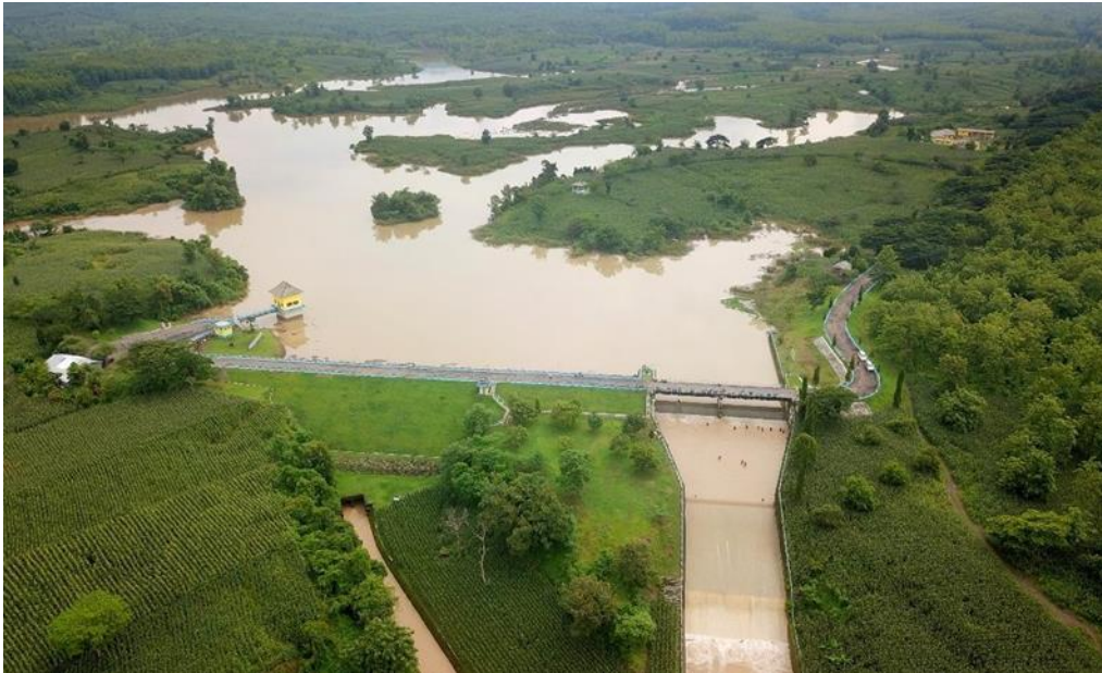
Gambar 1. 1 Kondisi Bendungan Kedung Brubus
