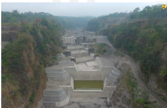
Gambar 3.6 Sabo Dam Tipe Terbuka
