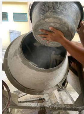
Gambar L-3.2 Pencampuran Bahan Penyusun Beton
