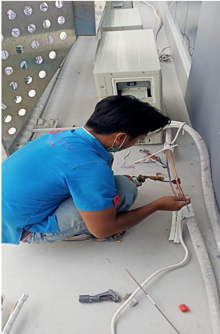
Gambar L-3.5 Proses Pengelasan Pipa Refrigerant
