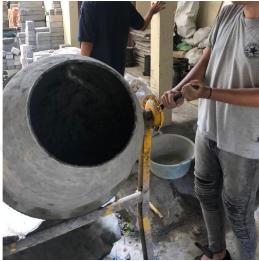
Gambar L-3.3 Pengadukan Campuran Beton
