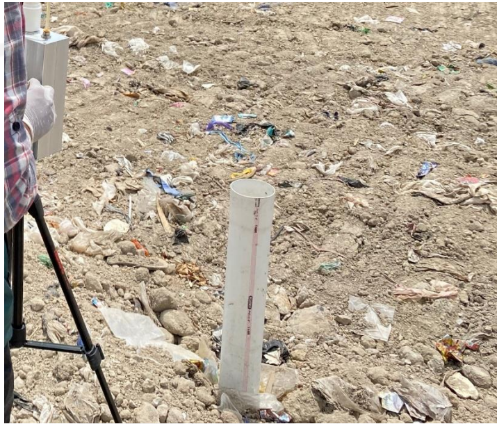
Gambar 4.8 Pipa Gas Yang Berada di Atas Sel I TPA Troketon Pedan Sumber : Dokumentasi Pribadi, 2021
