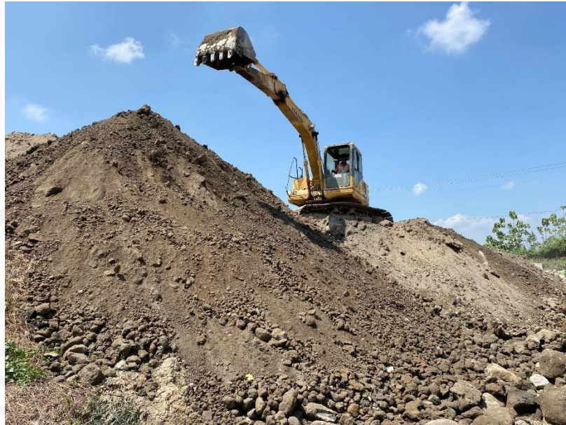
Gambar 4.9 Tanah Penutup Sel TPA Troketon Pedan
