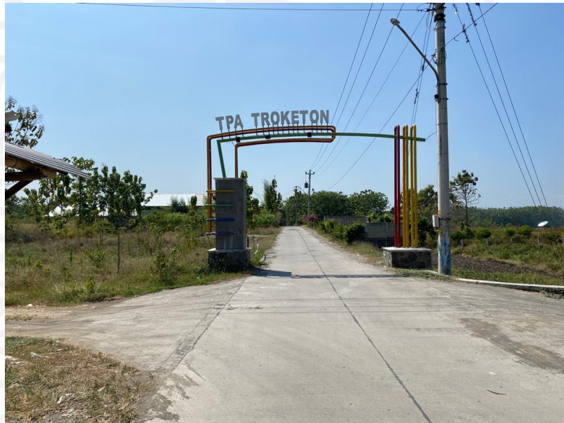
Gambar 4.1 Kondisi jalan masuk utama dari jalan raya menuju TPA Troketon Pedan
