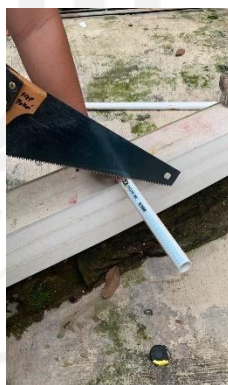
Gambar 4 - 1 Proses pemotongan pipa
