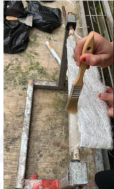
Gambar 4 - 7 Pelapisan serat kaca acak Lapisan 2
