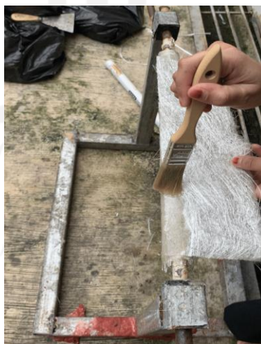
Gambar 4 - 9 Pemasangan serat kaca acak
