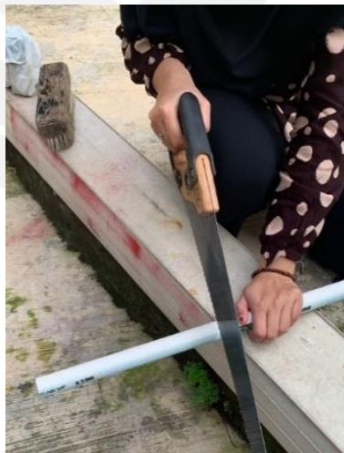
Gambar 4 - 1 Pemotongan pipa pvc
