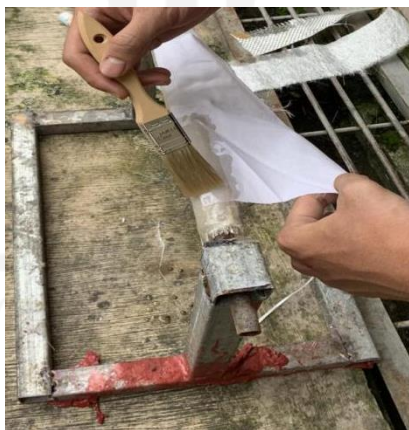
Gambar 4 - 7 Hasil Pemasangan Kain Mori.
