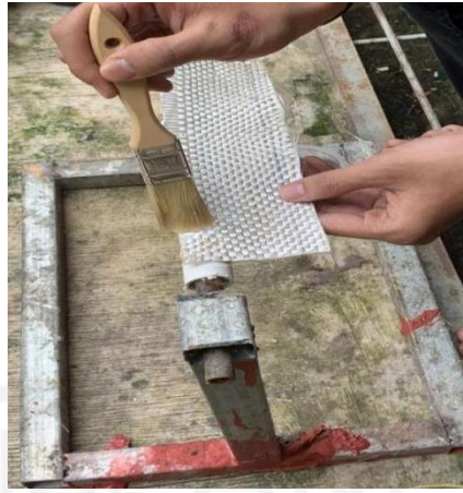
Gambar 4 - 6 Pemasangan Fiberglass Serat Anyam
