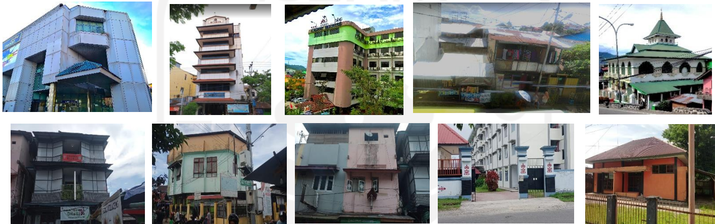
Gambar 95 Fasad Bangunan Vernakular dan Modern di Kawasan Kecamatan Sirimau
