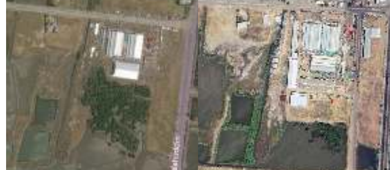
Gambar 3.12 Kondisi Pasar Raya Amahami sebelum selesai pembangunan Sumber: app.formit.autodesk.com
