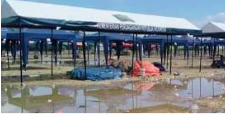
Gambar 1.3 Kondisi Pasar Raya Amahami Tergenang air Sumber: https://bimantika.net/pasar-amahami-di-genangi-air-laut-pemkot-bima-jangan-tutup-mata/
