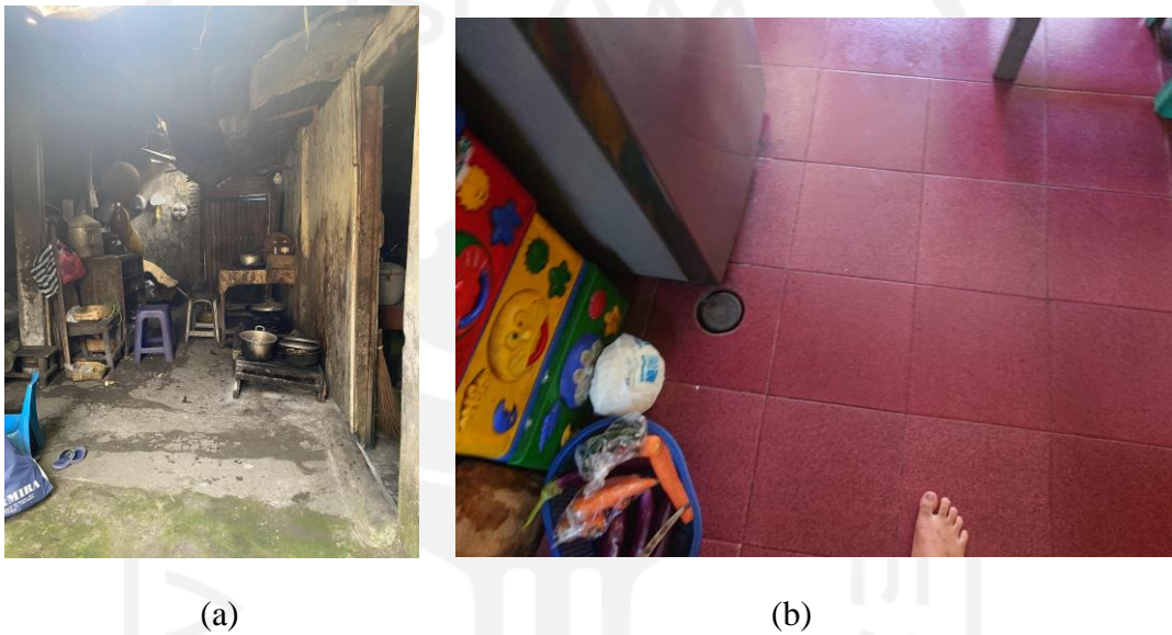
Gambar 4. 16 (a). Penutup Septic Tank SD 4 (b). Penutup Septic Tank SD 8
