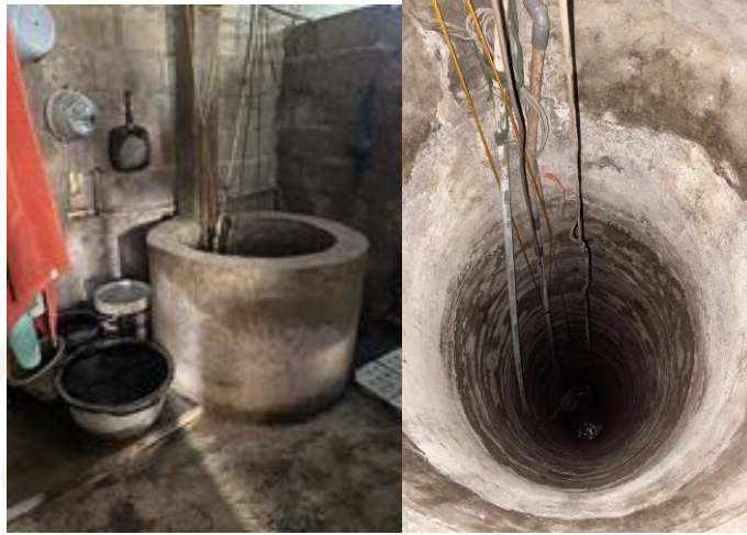
Gambar 4.2 Observasi Sumur Depok 2 (Sumber: Dokumentasi Pribadi, 2022)
