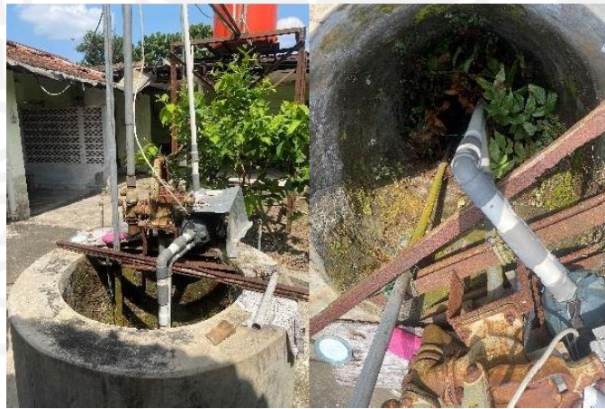
Gambar 4.1 Observasi Sumur Depok 1 (Sumber: Dokumentasi Pribadi, 2022)
