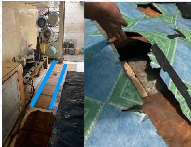
Gambar 4.6 Observasi Sumur Depok (Sumber: Dokumentasi Pribadi, 2022)
