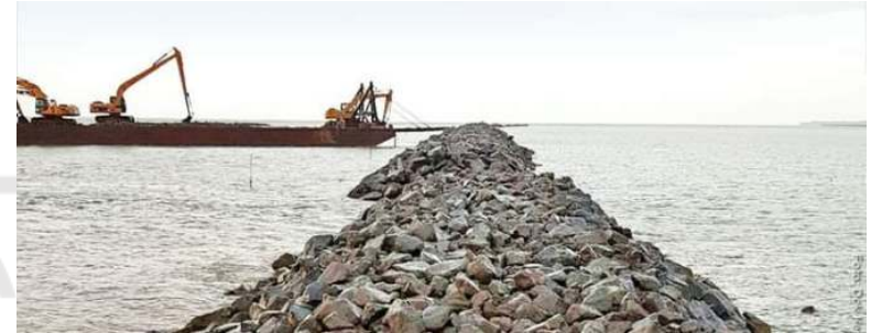
Gambar 1.15 Pembangunan Break Water
