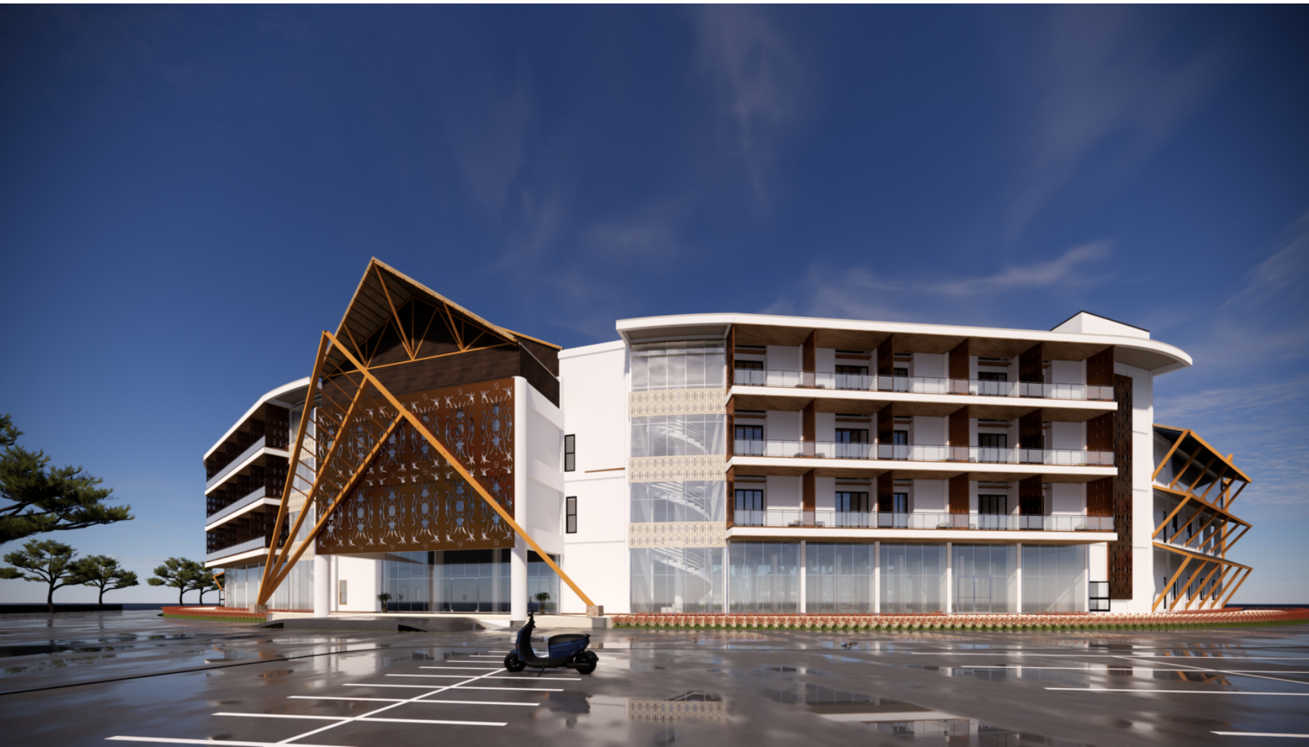
Gambar 4.40 Eksterior Bangunan Sumber : Penulis, 2022
