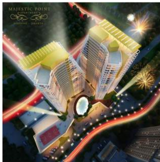
Gambar 1.69 Sky Park pada lantai teratas Apartemen Majestic Point, Serpong.
