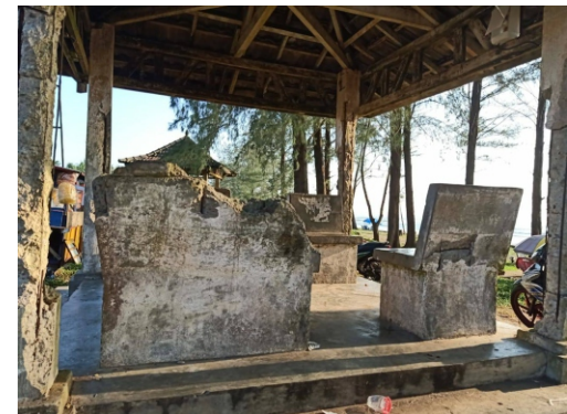
Gambar 1.6 Kondisi Eksisting Gazebo
