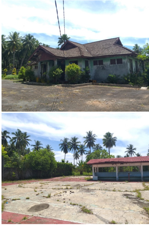
Gambar 1.3 Kondisi Eksisting Area Olahraga
