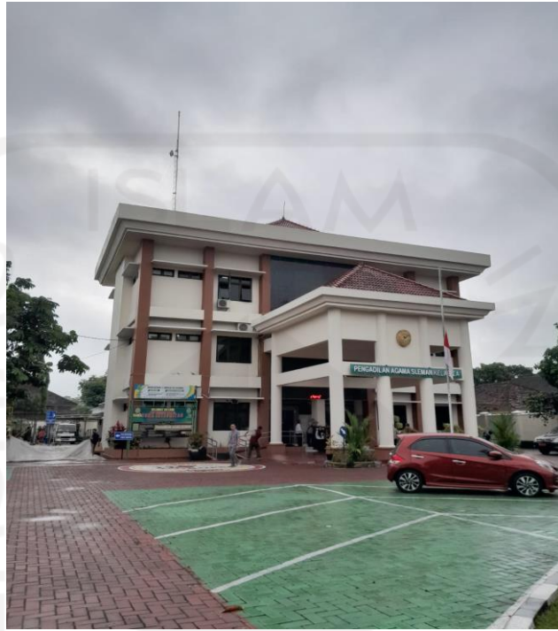
Gambar 1 Gedung Pengadilan Agama Sleman
