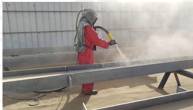
Gambar 5.6 Pekerjaan Sand Blasting
