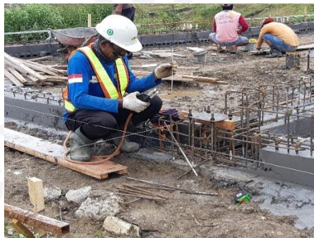
Gambar 5.7 Pemasangan Angkur
