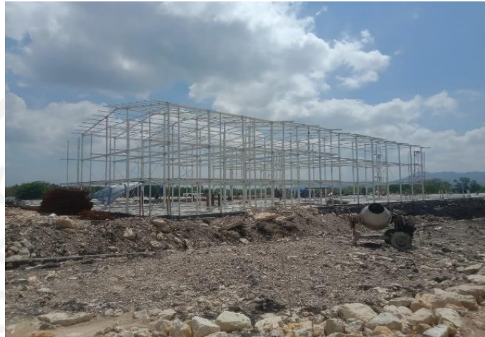
Gambar 1.1 Pembangunan Struktur Baja Pada Breeding Farm
