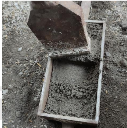
Gambar L-2.13 Pencetakan Paving Block Metode Konvensional
