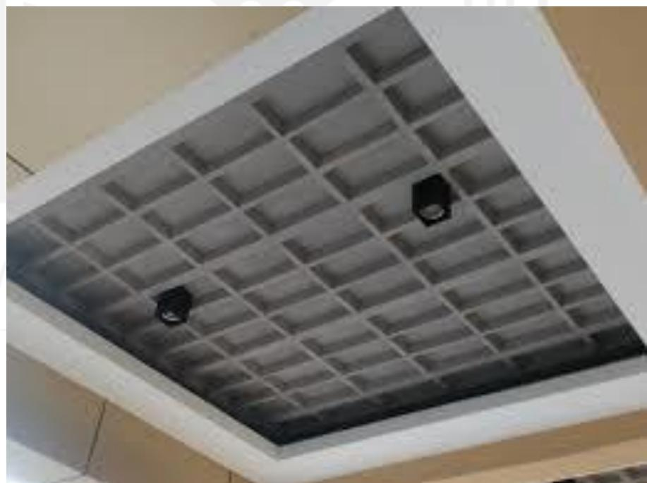
**Gambar 3.5** Beton Pracetak Flyslab yang sudah terinstal di Bangunan
