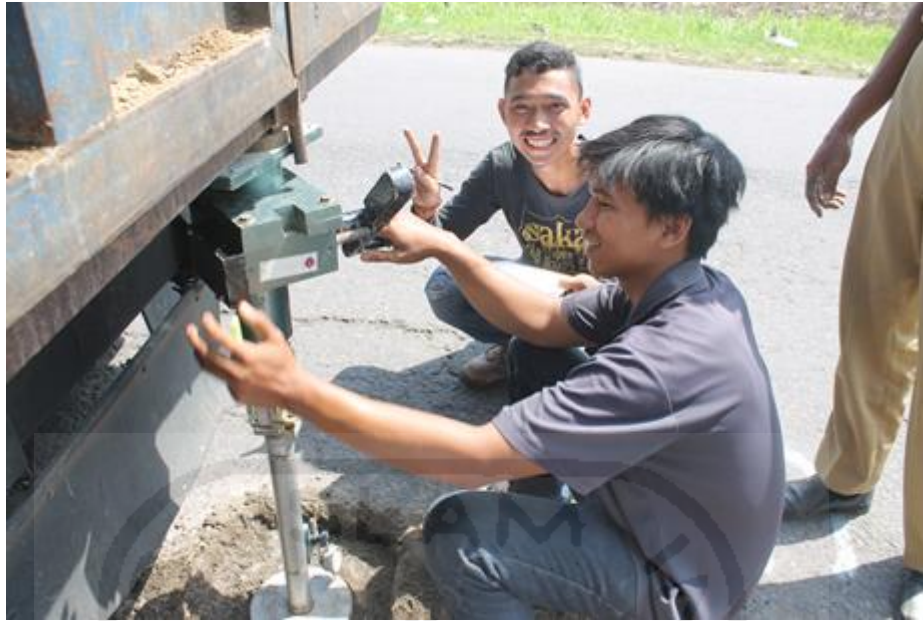
Gambar 2-13 Uji CBR Lapangan Sta. 10+900
