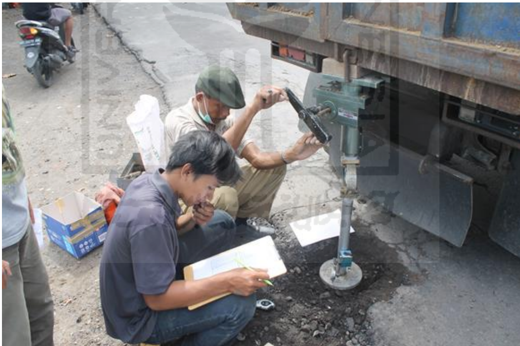
Gambar 2-12 Uji CBR Lapangan Sta. 12+700
