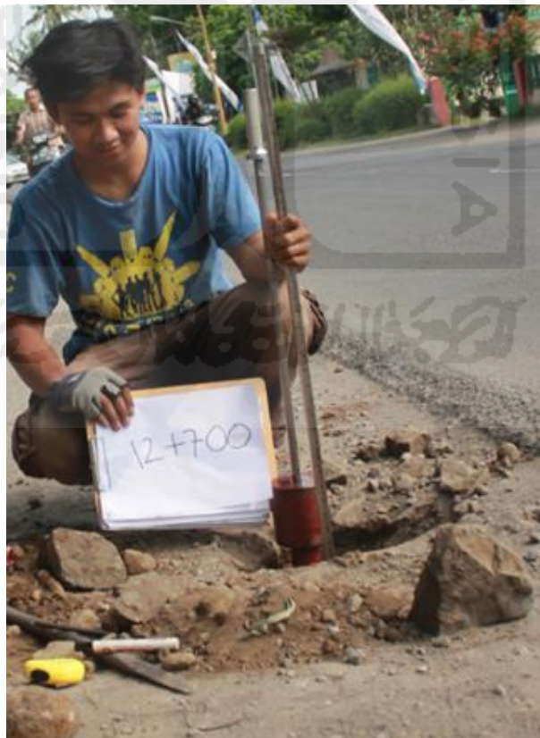
Gambar 2-10 Uji DCP Sta. 12+700
