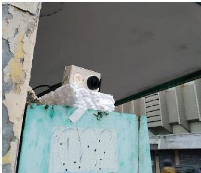
Gambar L-15.3 Kamera CCTV Pada Simpang Tiga KS Tubun
