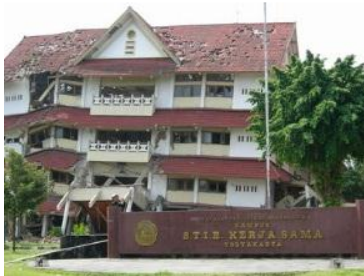
Gambar 1.2 Kerusakan gedung akibat gempa Yogyakarta 2006 (Sumber : http://ciptakarya.pu.go.id , 2006)
