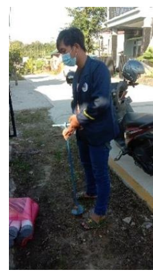
Gambar 6. Pembuatan Lubang Biopori
