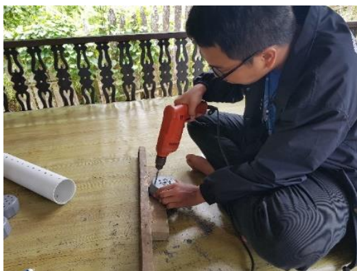
Gambar 5. Perakitan Pipa Biopori
