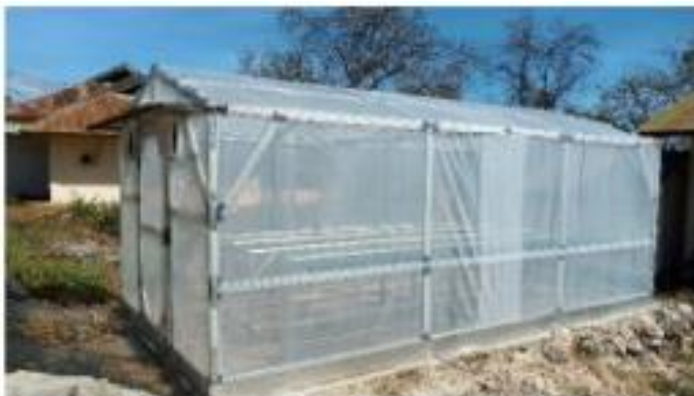
Gambar 4. Rumah plastic UV sederhana untuk proses pengeringan pinang betara
