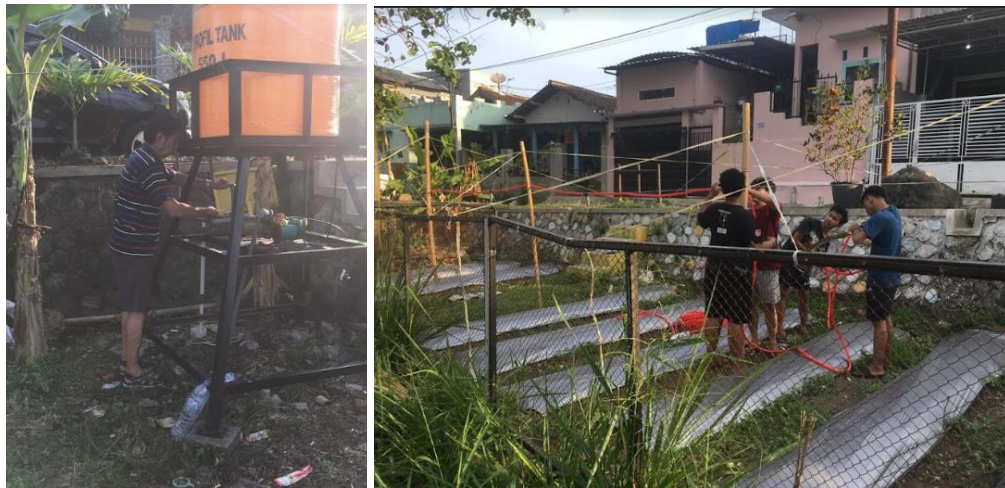
Gambar-4. Pemasangan Pipa dengan Model Spray
