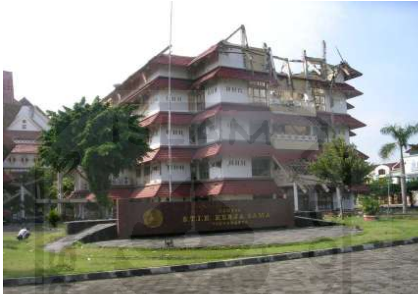
Gambar 1.2 Gedung fasilitas pendidikan yang runtuh akibat gempa Yogyakarta 2006 (tephenomena.wordpress.com)
