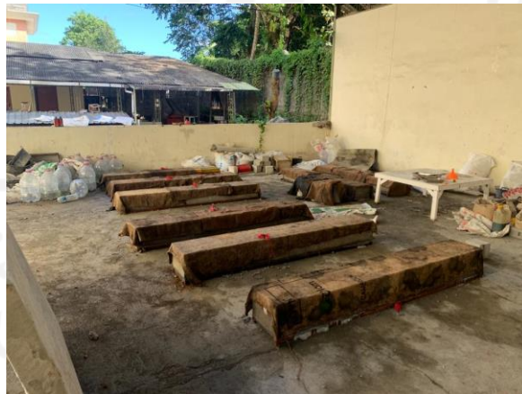
Gambar L-2.5 Proses Curing Menggunakan Karung Goni
