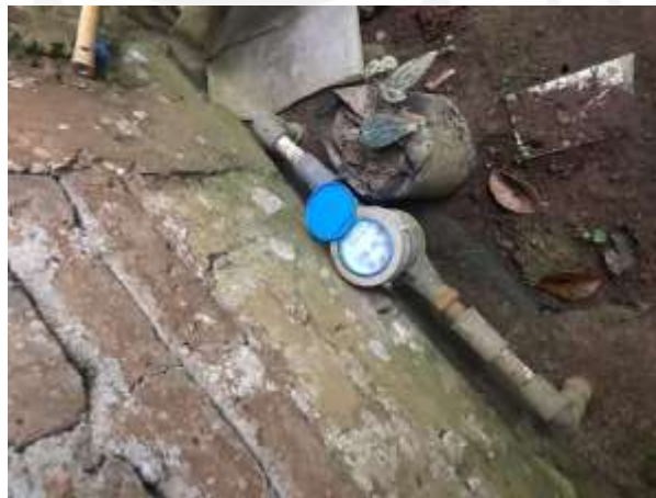
Gambar 4.20 Watermeter di Rumah Warga
