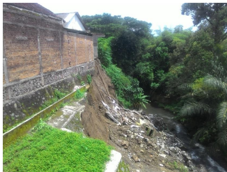
Gambar 1.2 Kondisi Lereng di Lapangan
