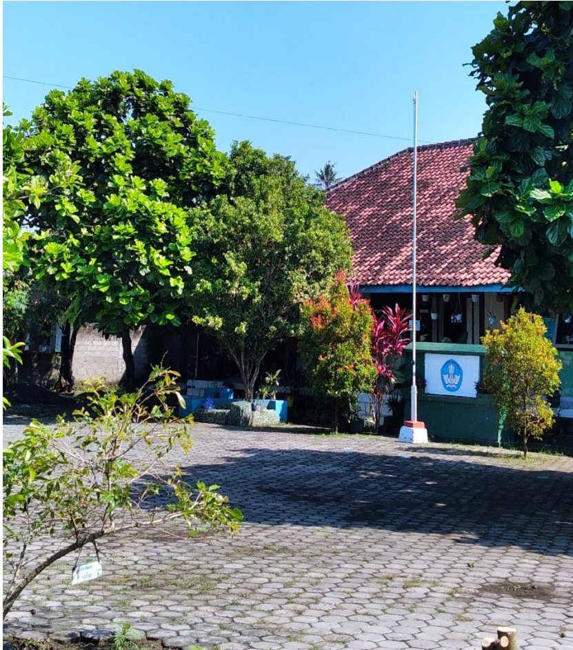
Gambar 3.1 Bangunan SDN Kledokan
