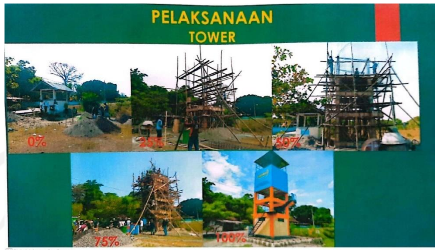
Gambar 4.7 Pelaksanaan Pembangunan Tower dan Reservoir Pamsimas
