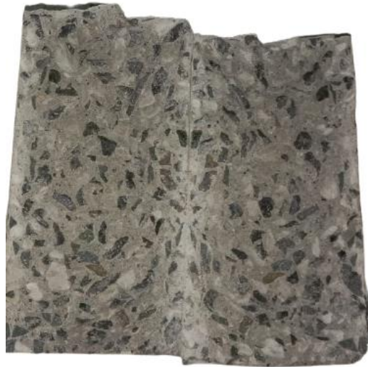
Gambar 5.19 Beton Uji CT 1 Setelah Pengujian Kuat Tarik Belah
