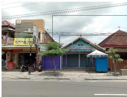
Bangunan U20 / warung
