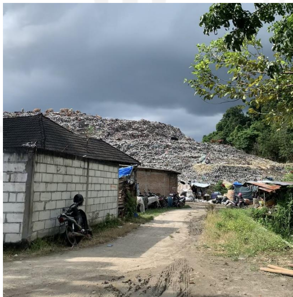
Gambar 2.1 Kondisi TPST Piyungan
