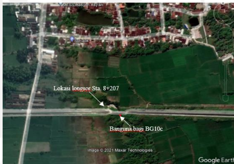
Gambar 1.1 Lokasi Longsor Sta. 8+207
