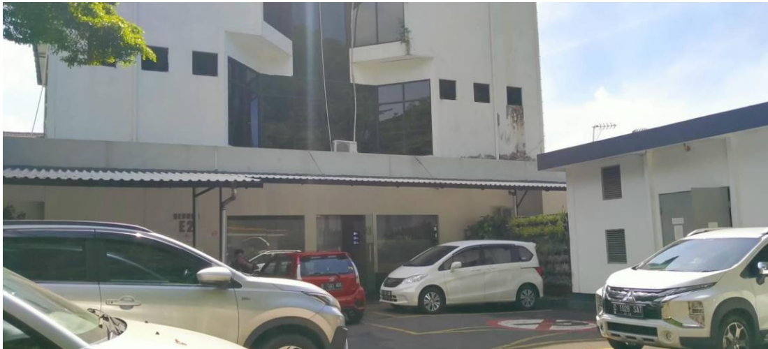
Gambar 1.3 Gedung E2 Kantor Pusat Kereta Api Indonesia di Bandung
