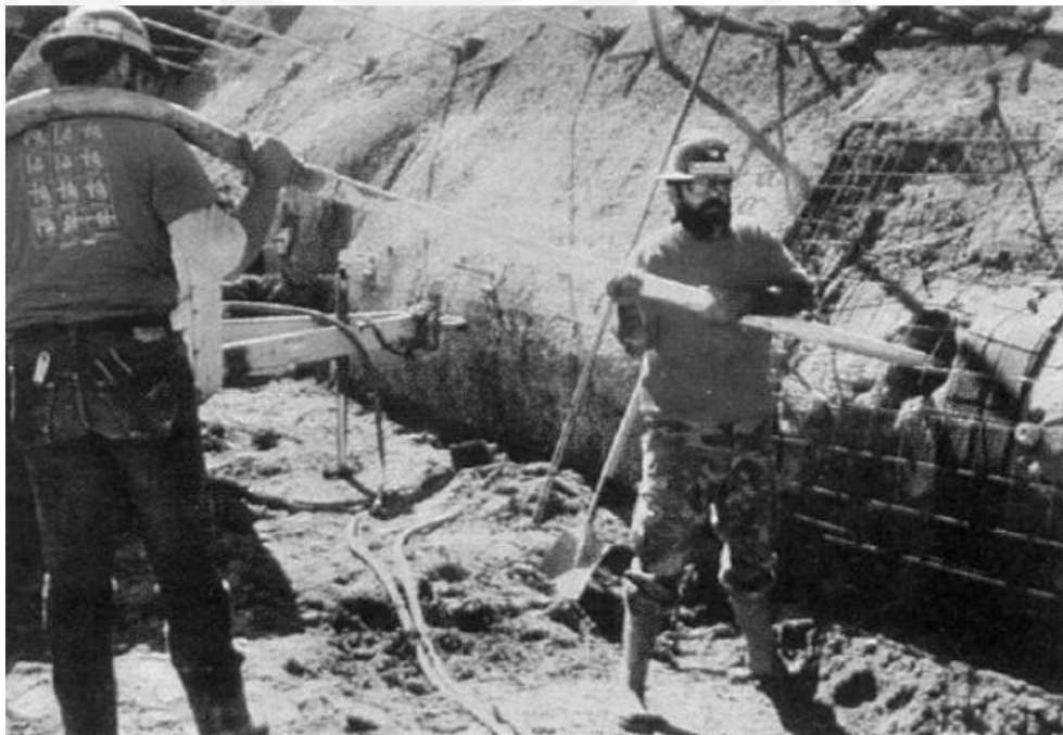
Gambar 3.19 Grouting dengan Menggunakan Pipa Tremi (Sumber: FHWA0-IF-03-017, 2003)
