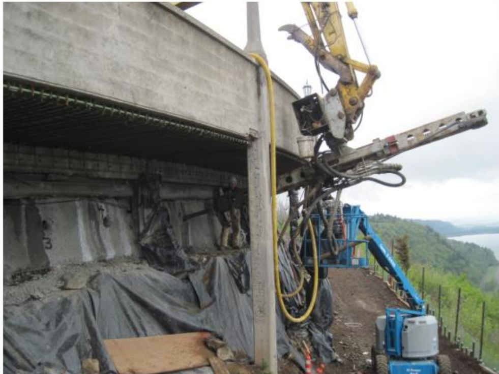
Gambar 3.18 Pemboran Lubang Nail
