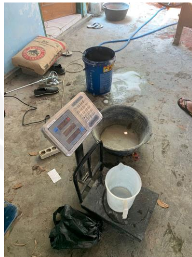
Gambar L-1.6 Persiapan Material Campuran Bata Ringan
