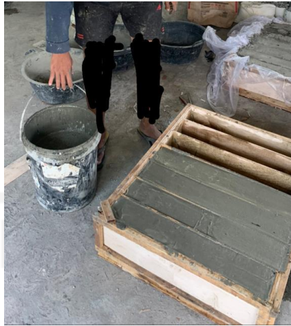
Gambar L-1.8 Penuangan Adonan ke Cetakan
