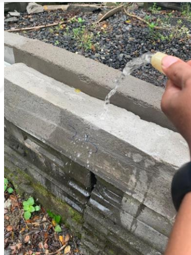
Gambar L-1.10 Curing Bata Ringan
