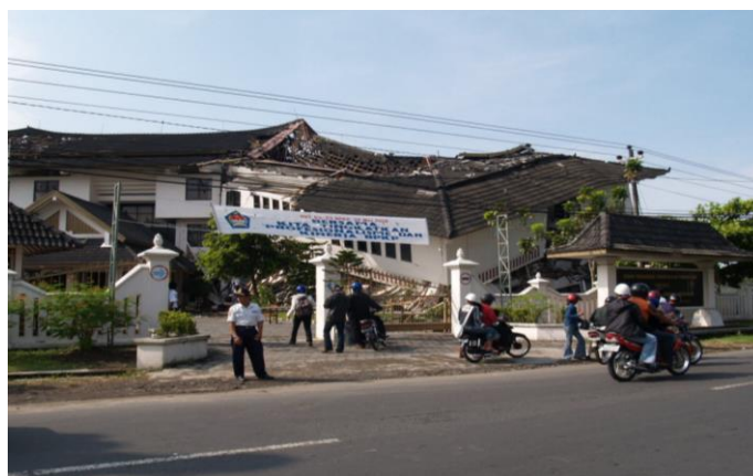
Gambar 1.2 Kerusakan bangunan akibat gempa (Gedung Badan Pengawasan Keuangan dan Pembangunan di Parangtritis)
